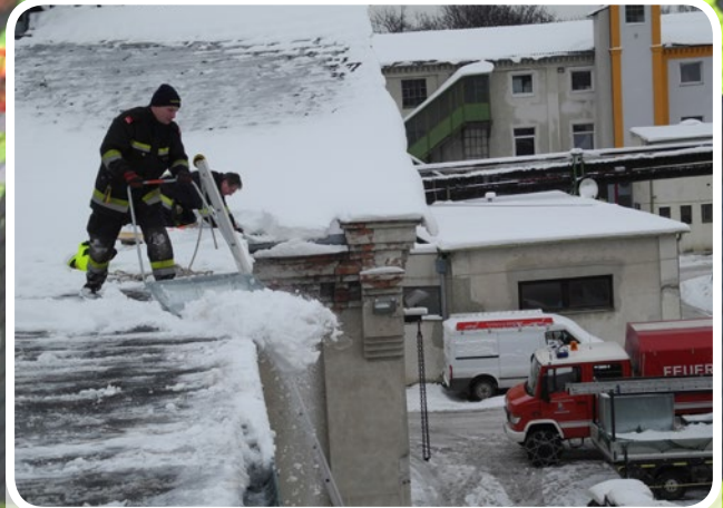
Wassereinbruch in der Druckfabrik, freimachen des Daches und der Dachrinnen von Schnee und Eis
