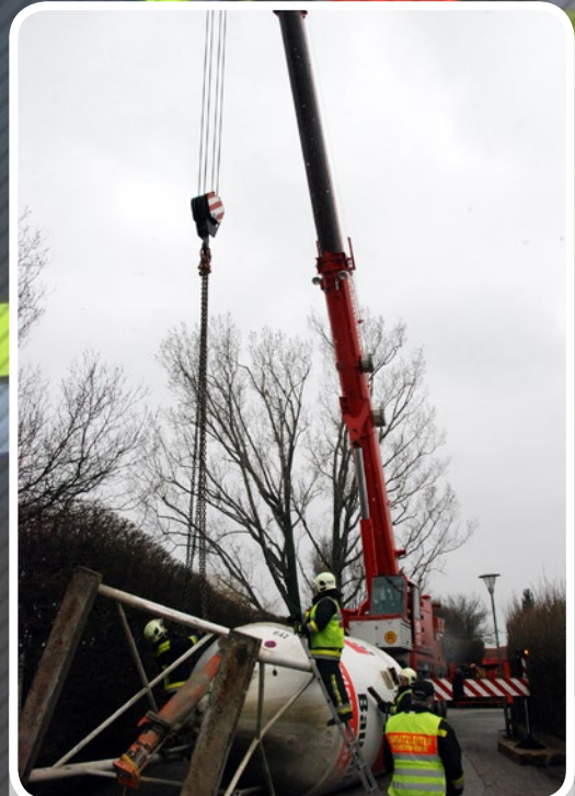
Umgestürzter Baustoffsilo, Cle- matisweg. Dieser wurde mit dem Kranfahrzeug des NÖ Landesfeu- erwehrverbandes, welches bei der FF Mödling stationiert ist, ge- sichert am Straßenrand abgelegt um dem Störtrupp der Gaswerke den Zugang zu der beschädigten Gasleitung zu ermöglichen
