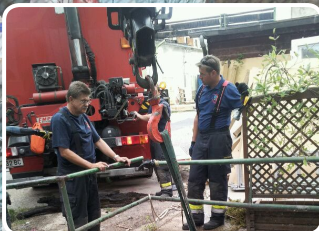
Entfernen von Verkläuerungen im Mühlbach
