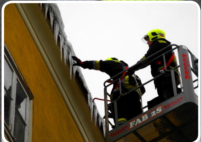
Entfernen von Eiszapfen mit dem Arbeitskorb des Schweren Rüstfahrzeuges in Gumpoldskirchen
